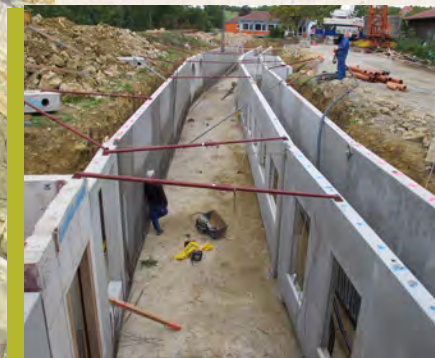
Der Entschleunigungs-Gang entsteht
