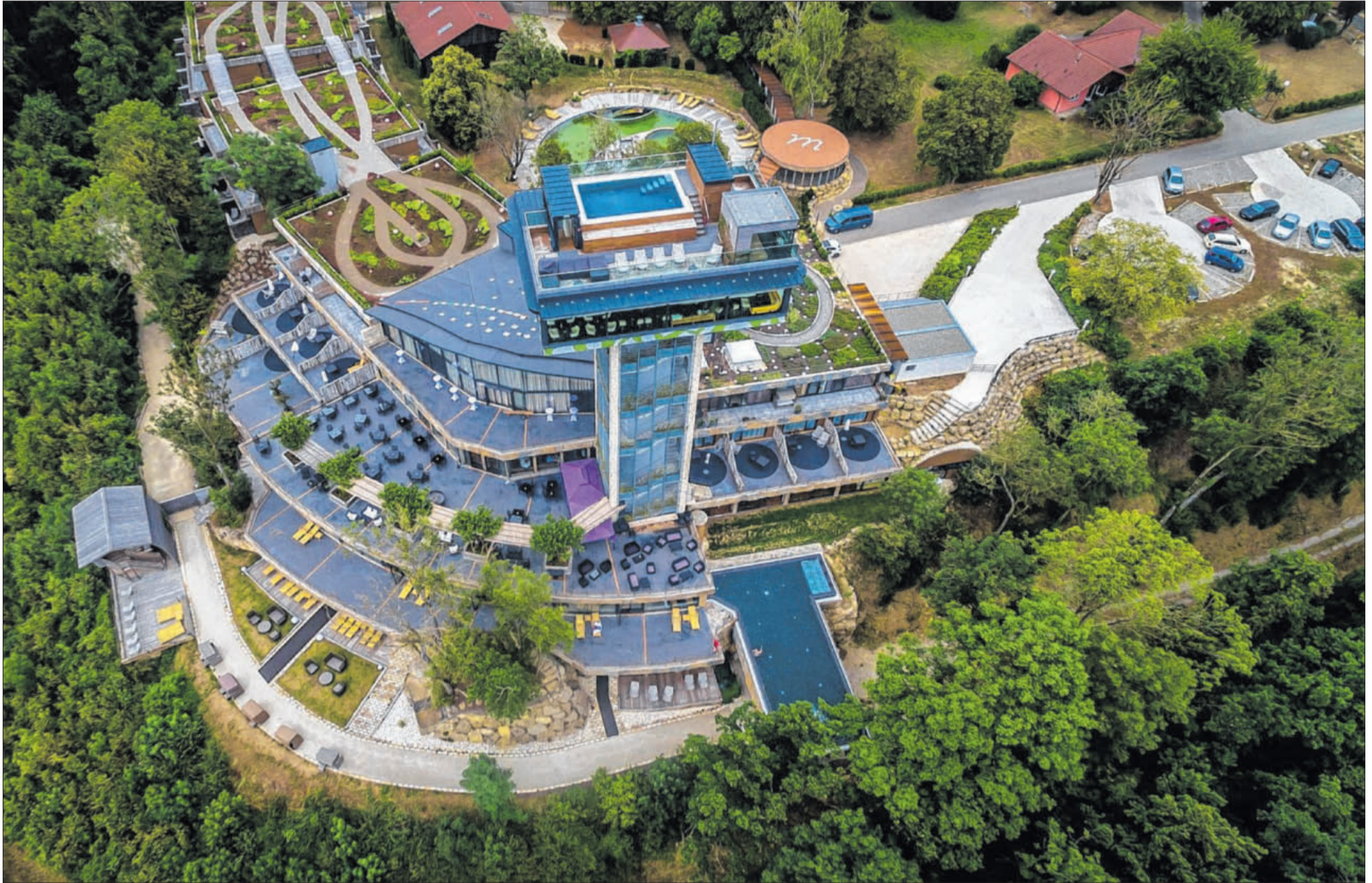
Neben dem Schloss ist das Mawell Resort der touristische Magnet in Langenburg. Dessen Untergeschoss wurde in den Muschelkalk hineingetrieben.
