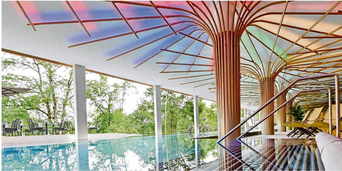
Das 50 Meter lange Sportbecken ist einer der größten Hotelpools Europas und liegt direkt an der Hangkante. Im Sommer bleibt die Panorama-Glasfassade geöffnet und gibt so den direkten Blick auf das Jagsttal frei. Foto: Mawell Resort
